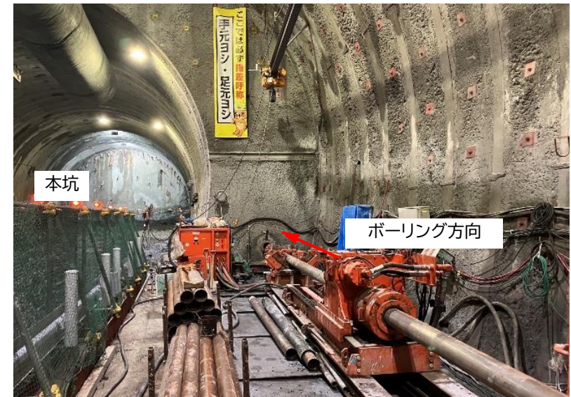
台場山工区ボーリング削孔状況
