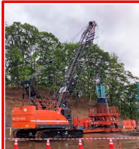
岩塊撤去状況
