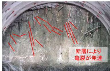
【特徴1】断層運動に伴う弱部の形成
