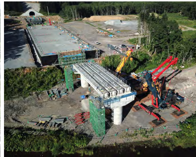
PCU形桁 架設状況
