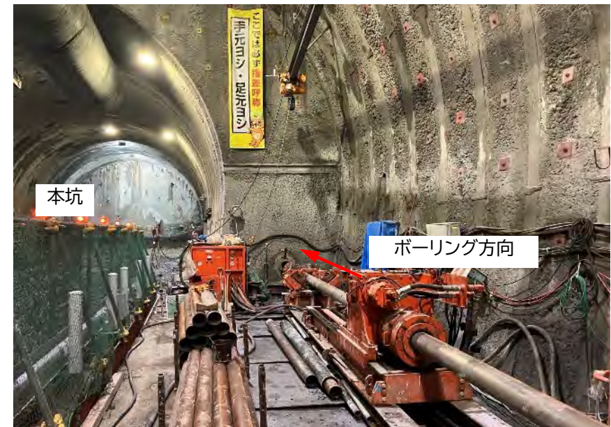
台場山工区ボーリング削孔状況
