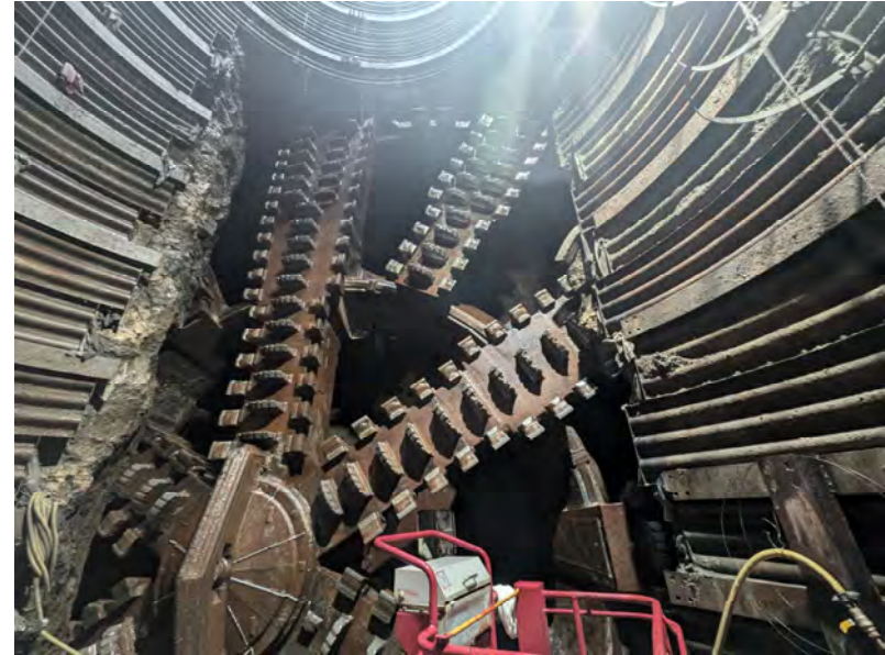
羊蹄トンネル(比羅夫) 中間立坑マシン面版
