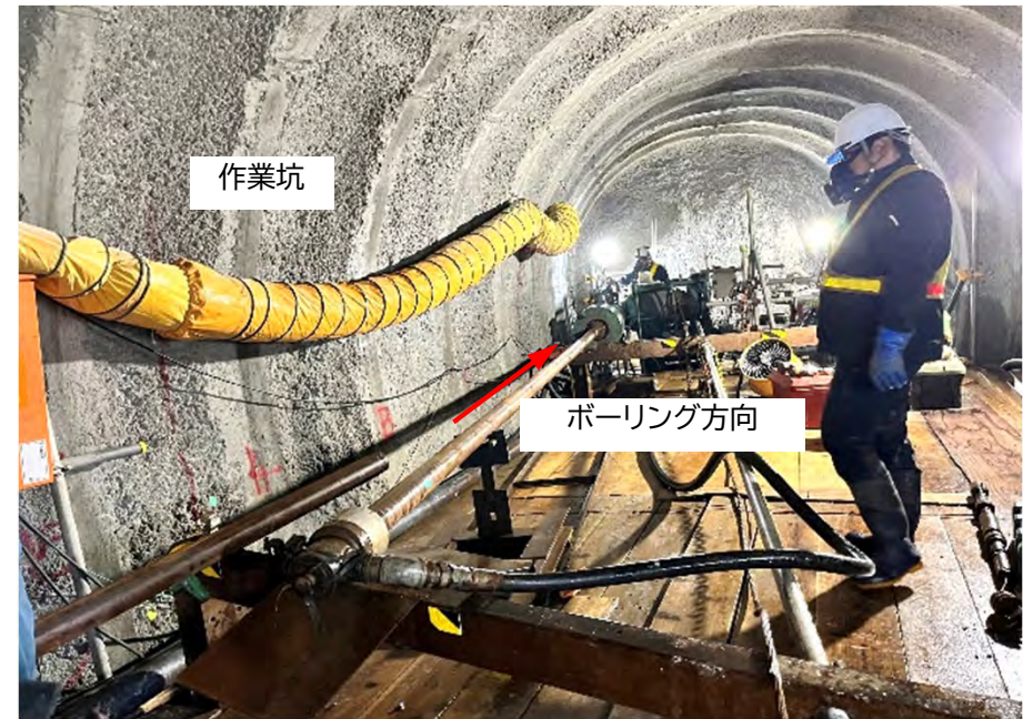
南鶉工区ボーリング削孔状況
