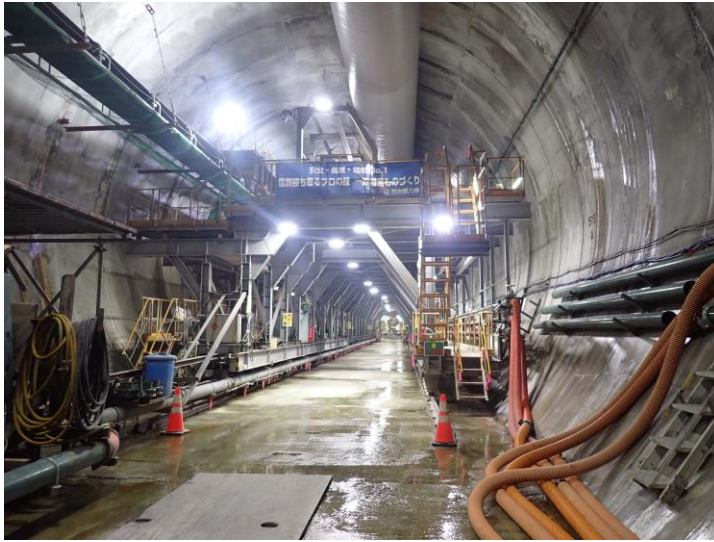
羊蹄トンネル(有島) 坑内状況
