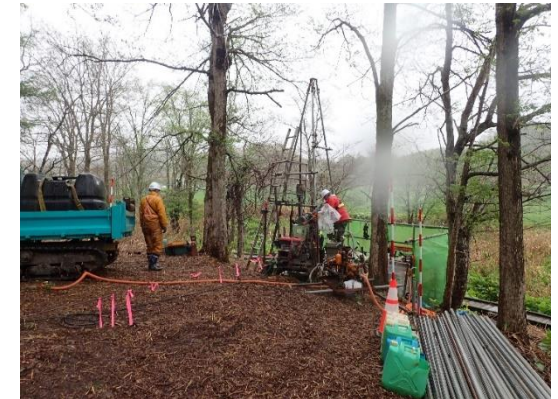
ボーリング調査状況
