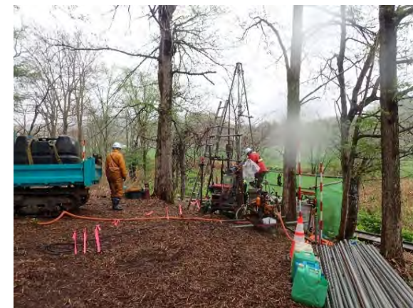
ボーリング調査状況
