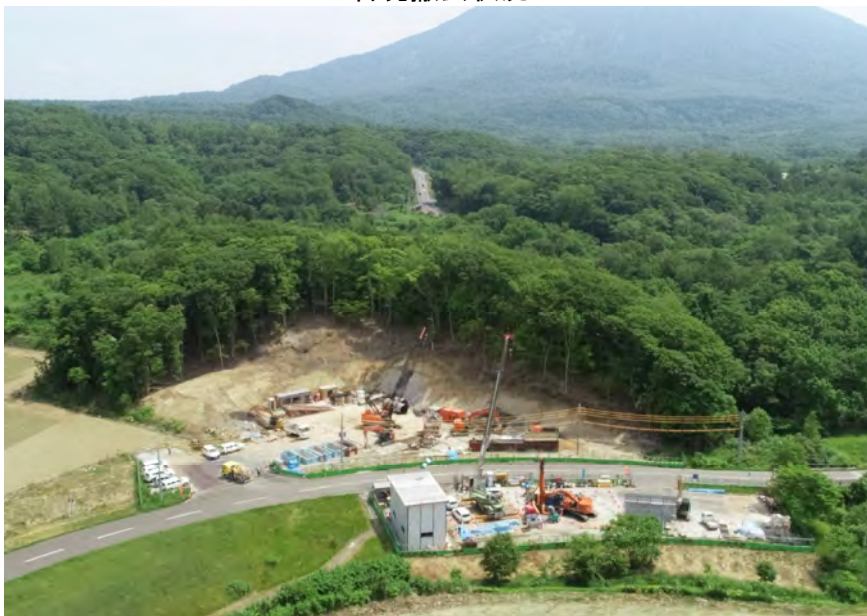
羊蹄トンネル(有島) 岩塊撤去状況
