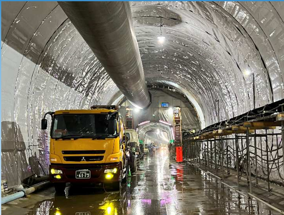
覆工コンクリート打設状況
