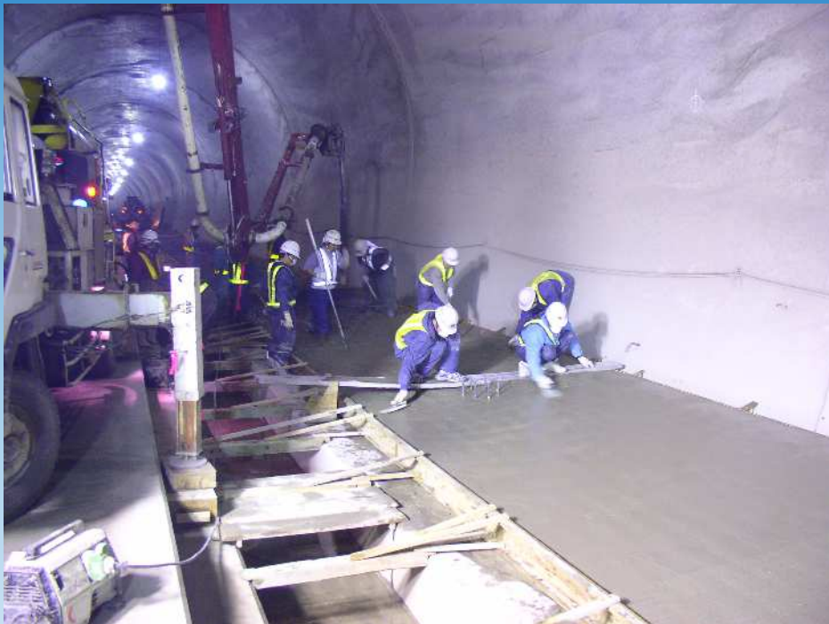
路盤鉄筋コンクリート打設状況
