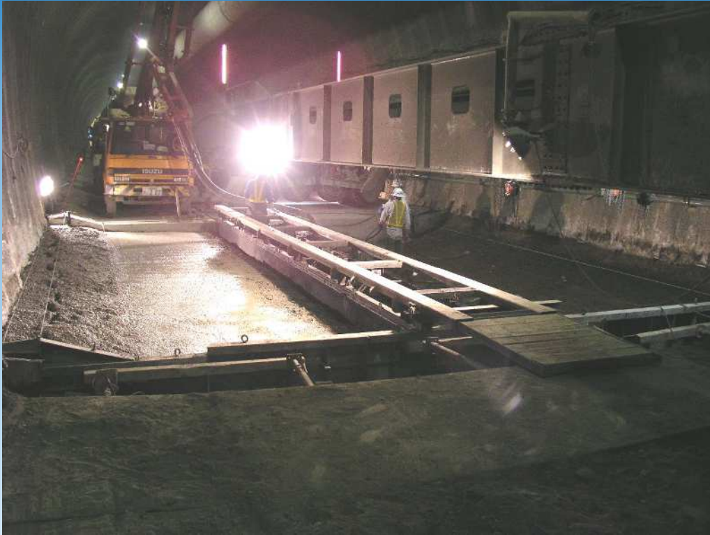
インバートコンクリート打設状況
