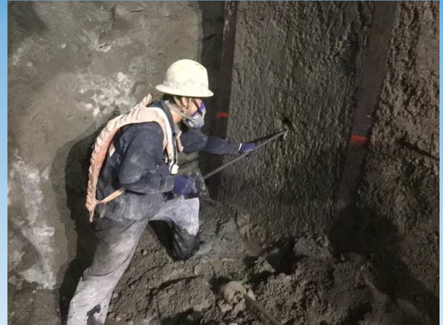
ロックボルト挿入
