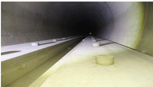
村山トンネル
