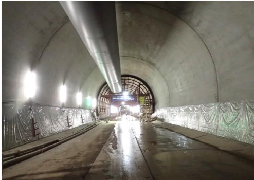
ニッ森トンネル (鹿子)
