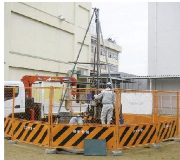
ボーリング調査
