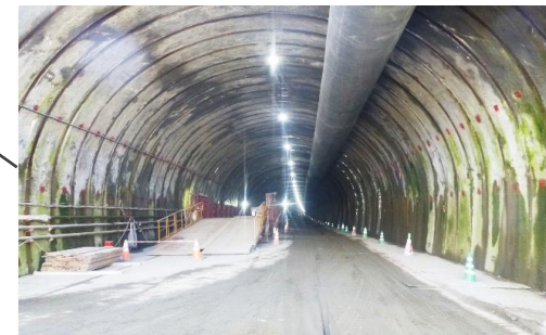
国縫トンネル
