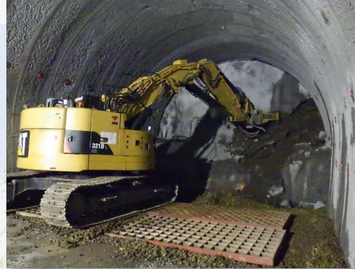
札幌トンネル(富丘工区)
