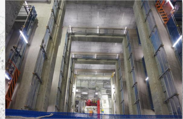
札幌トンネル(札幌工区)
