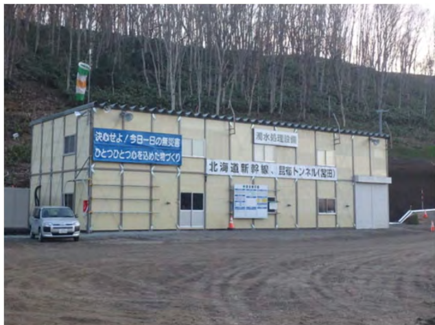
【写真】濁水処理設備（例）外観
