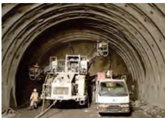
ロックボルト施工
