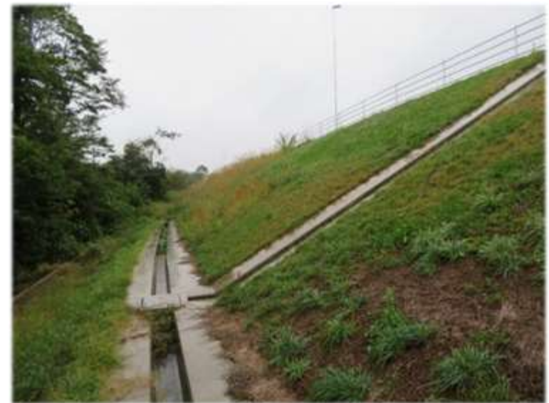
盛土斜面の整備状況の例
