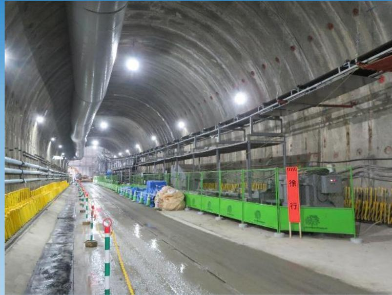
トンネルの中のベルトコンベヤ
