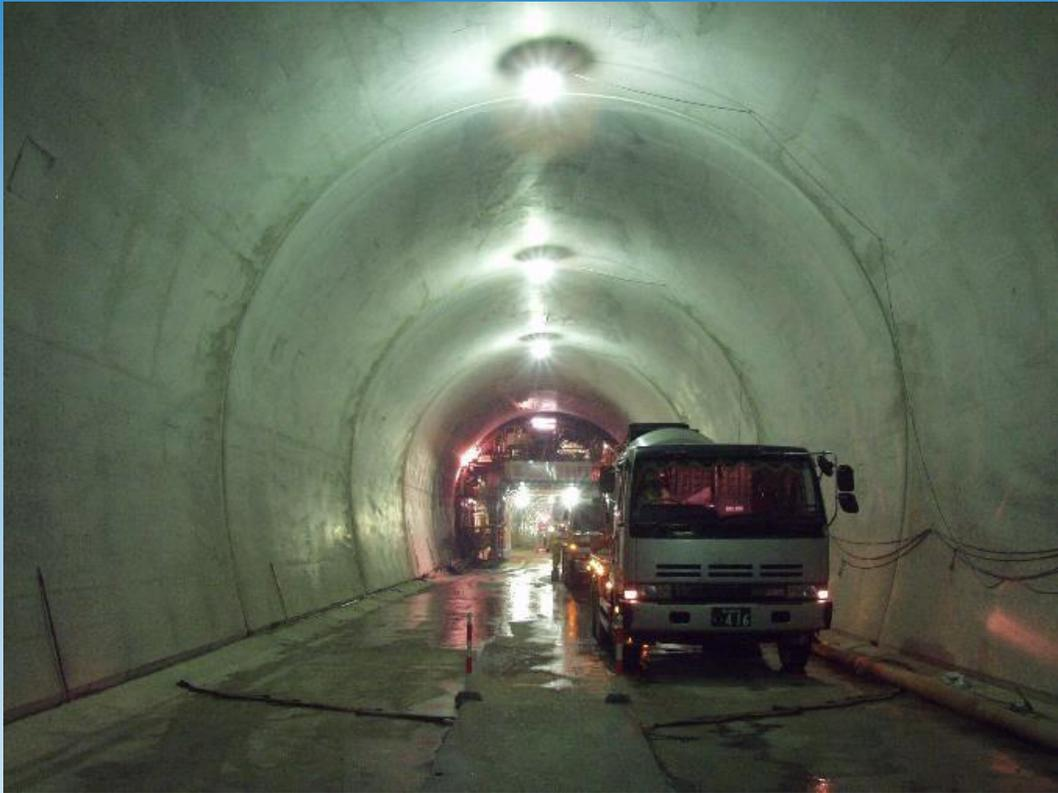
覆工コンクリート打設状況
