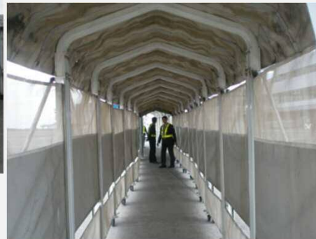
図 2(2)-23 静岡空港のエプロンルーフ
