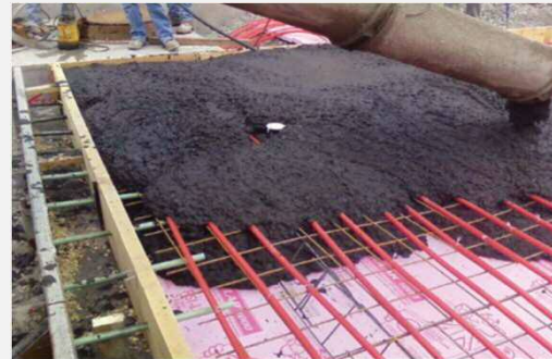
図 2(2)-15 海外空港のロードヒーティング事例 資料：米国グレートー ビンガムトン空港
