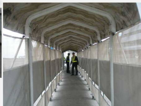
図 2(2)-23 静岡空港のエプロンルーフ
