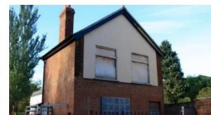
コミュニティ・ランド・トラスト(イングランド リバプール) 17
