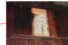
内壁内部土壁部分
