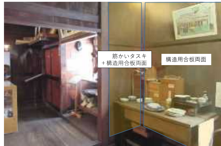
○R通り13-14間補強(東面)、14通りR~T間補強(南面)
