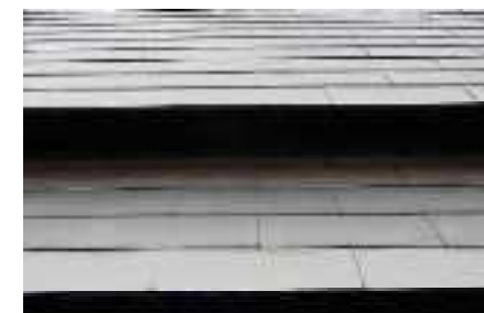
写真6：南側屋根（拡大）
