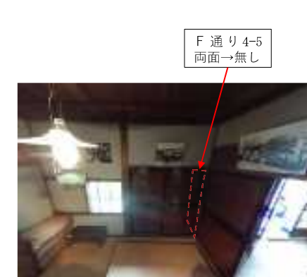
F通り耐震壁設置変更部分（表六畳側）
