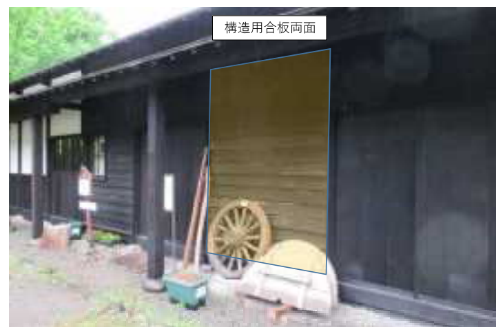
○V通り13-14間補強(東面)
