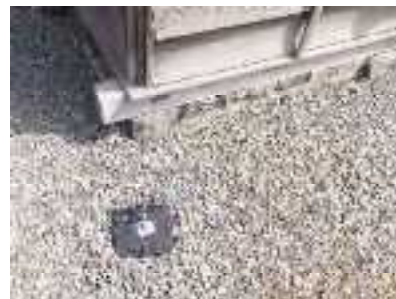
参考写真4：装置設置状況(地面)
