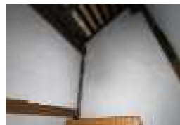
内壁土壁部分
