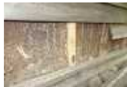
外壁内部土壁部分
