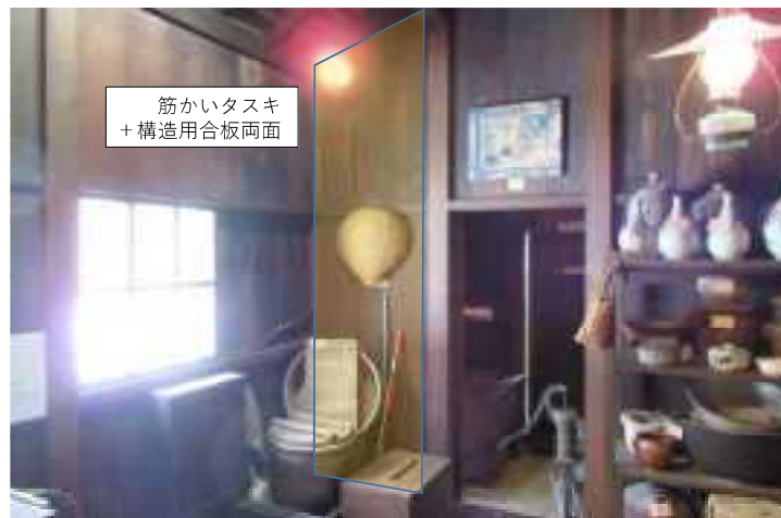
○V通り13-14間補強(西面)
