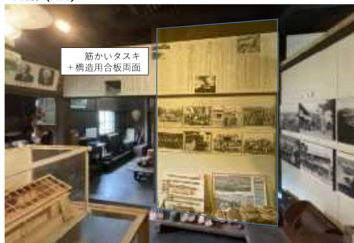
○R通り9-11間補強(西面)
