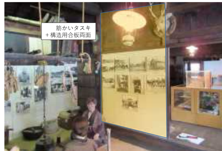
○R通り9-11間補強(東面)
