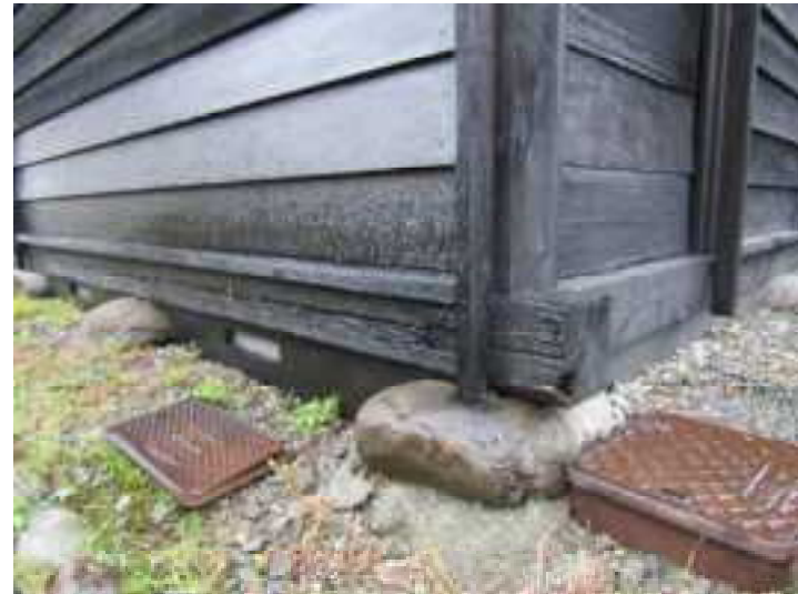
写真1：土台修理部 a
