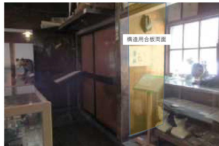
○P通り13-14間補強(東面)
