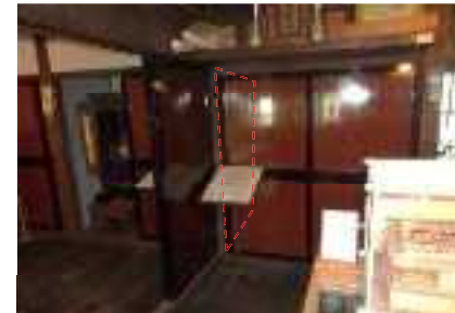
N通り耐震壁設置部分（居間側）
