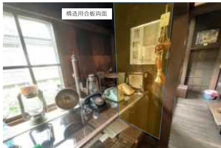
○R通り13-14間補強(西面)
