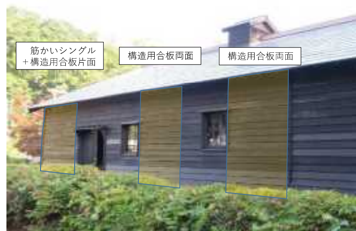
○14通りN-P、R-T、W-Z間補強(北面)
