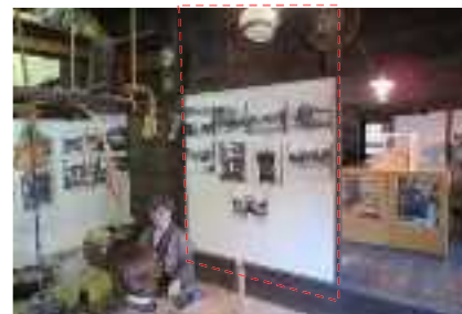
R通り耐震壁設置部分（台所側）
