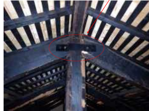
柱欠損部（埋木補修）
