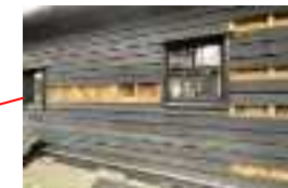
外壁内部すじかい部分
