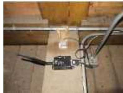
参考写真2：装置設置状況(梁上)
