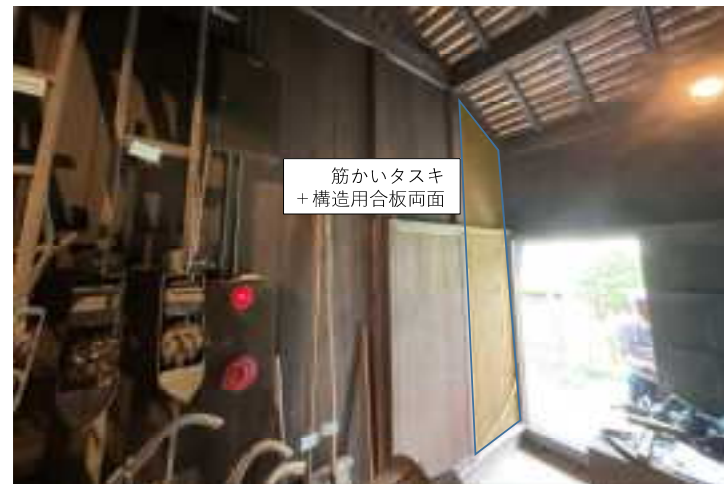
○V通り13-14間補強(東面)
