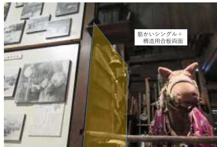
○7通りW-Z間補強(南面)
