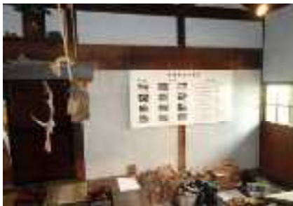
N通り耐震壁設置部分（旧玄関側）
