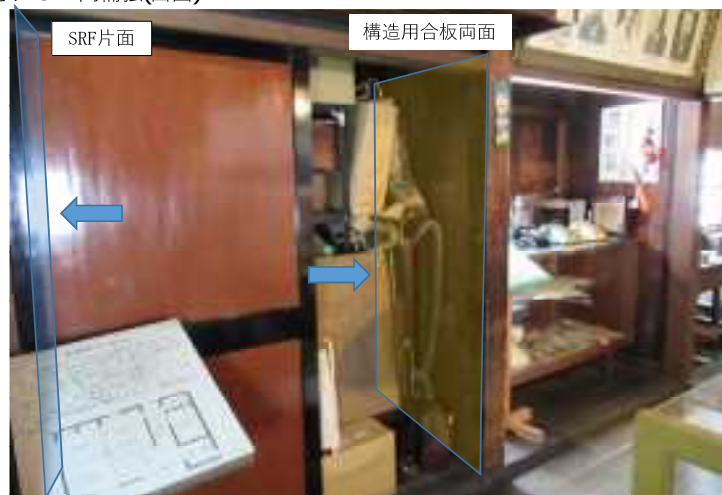
○N、P通り13-14間補強(西面)
