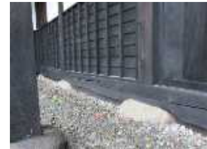
参考写真2：土台部(旧黒岩住宅)
