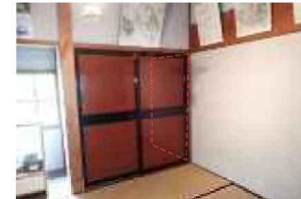
J通り耐震壁設置部分（裏六畳側）
