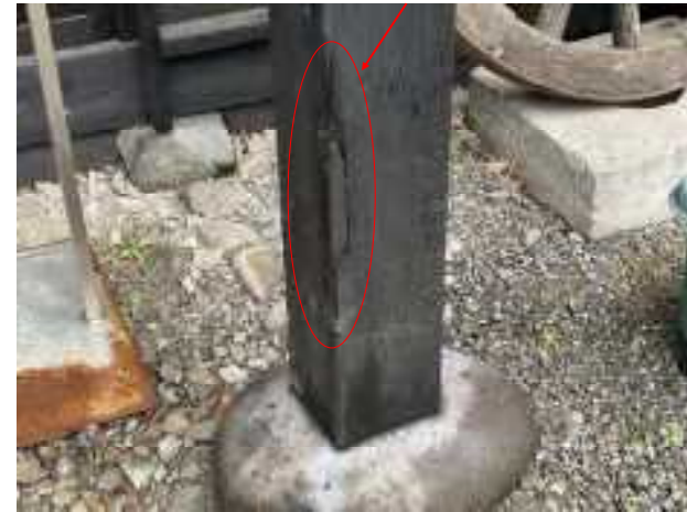
柱欠損部（埋木補修）
