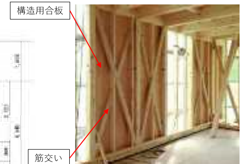
参考写真：構造用合板、筋交い
