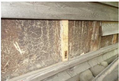
外壁内部土壁部分
