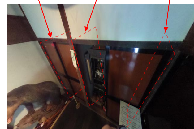
J～N通り耐震壁設置変更部分（広間側）
