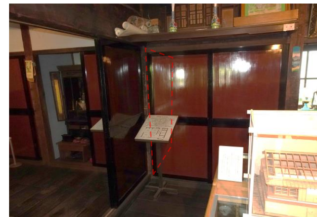
N通り耐震壁設置部分（居間側）
