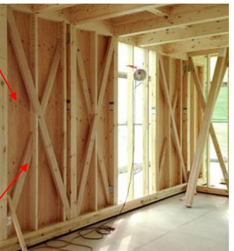
参考写真：構造用合板、筋交い
