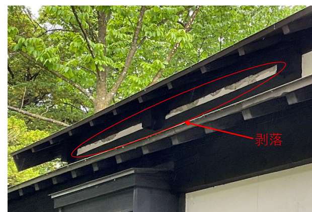
写真 7：南側外壁 漆喰劣化部分1
