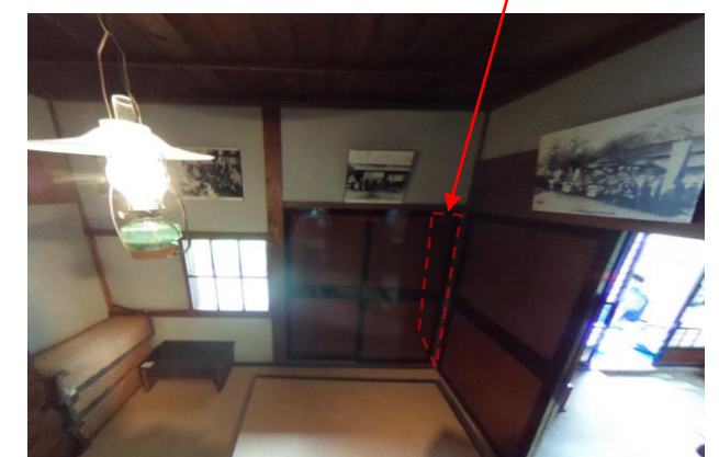
F通り耐震壁設置変更部分（表六畳側）
