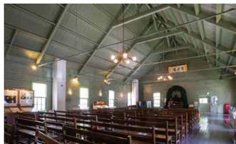
のき 軒けたはタイバー(丸鉄棒)で結び、さらに上方のつなぎ材の両端から鉄棒を下げてタイバーを釣っている。これはバルーン・フレーム構造(間柱構造)にみられる形式である。
