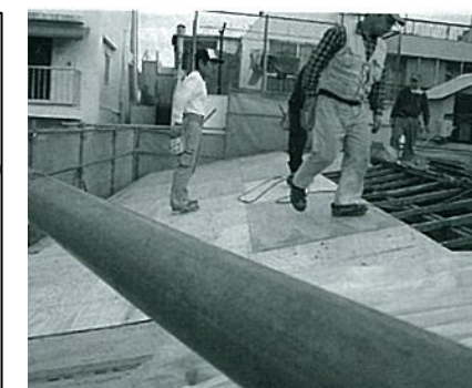
構造用合板による補強例
