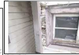
劣化番号1 下見板の腐食及び 窓枠のゆがみ、腐食
