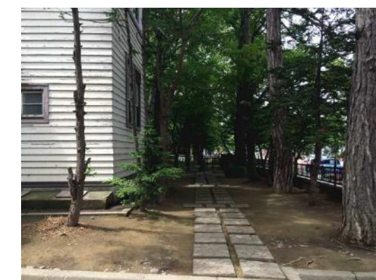
東側へ回り込む飛び石の通路も舗装環境の改善が必要
