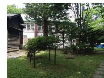
樹木によって隠れる南東側からの旧三菱鉱業寮の外観
