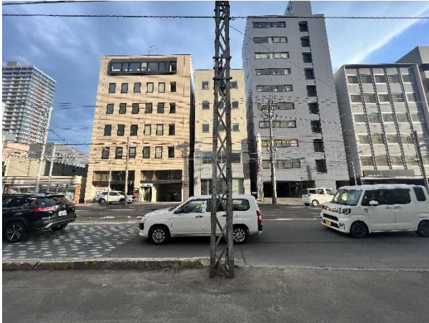
「中央区役所前」停留場近くにある鉄塔型の架線柱。中央に見える細いビルの場所に分岐軌道があった
