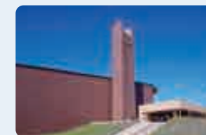
旧美香保屋内スケート競技場(現・美香保体育館) 東区北22条東5丁目
