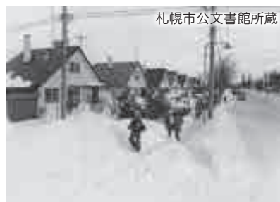
戦後に広まったコンクリート ブロック住宅
