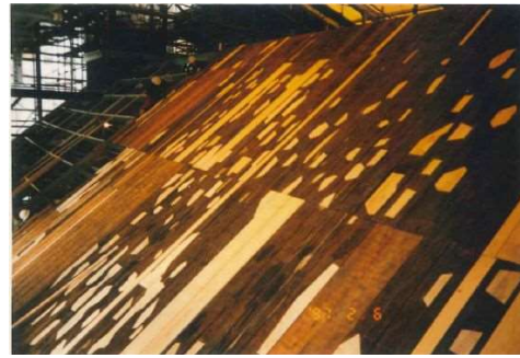
2. 補修済野地板(t30)の設置
