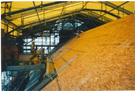
3. 構造用パネル(t12.5)の設置
