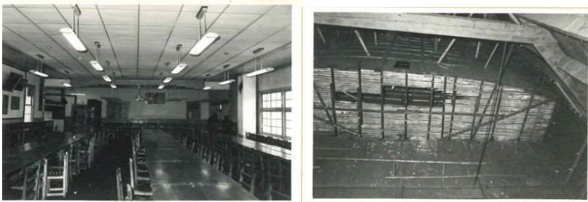
昭和42年復原工事での写真(※下記の説明書きは当時の記載文のまま) 左:2階閲覧室(東側より) 右:2階閲覧室上部小屋裏内に残存している大正13年5月修築時に造られたかまぼこ型天井
