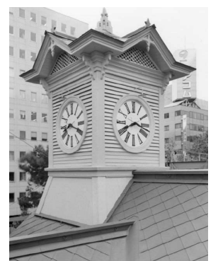
時計塔と屋根の取り合い
