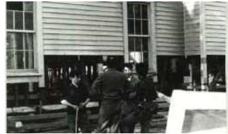
昭和42年時計台補修工事 工事写真（南面） 土台入れ替えに伴い、全周に渡り下側の下見板は新材に取替
