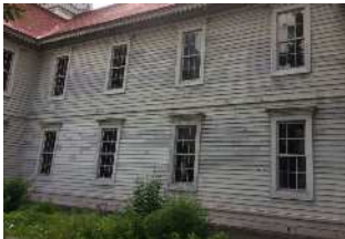
平成30年 外部改修工事前
