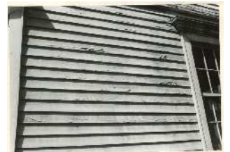
昭和46年外部塗装前(どの面かは不明) 南面だとすると、下側が剥離少ない傾向は今と同じ
