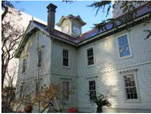
平成30年 外部改修工事後
