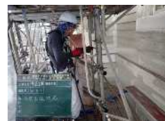
平成30年の外部改修工事で表面洗浄
