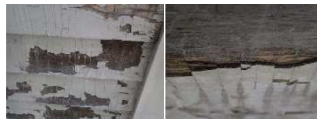
平成30年の外部改修工事で残した塗膜
