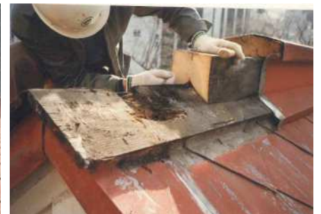
※化粧棟木腐朽箇所切断
