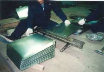
※バツタで「はぜ」をつくる様子。 (H10年保存修理工事の工事写真)
