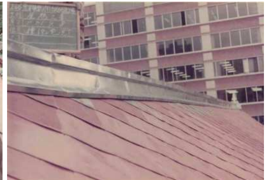
※本屋棟笠木外包完了
