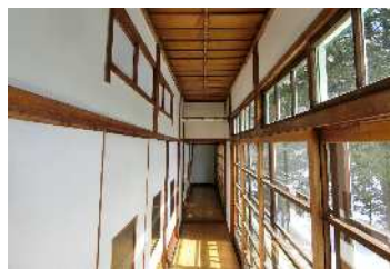
旧三菱鉱業寮の二重窓
