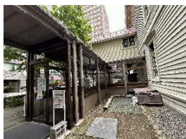
簡易廊下裏に置かれた資材
