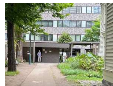
写真⑥ トイレ棟
