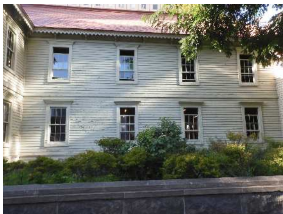
調査写真1. 南面外壁
