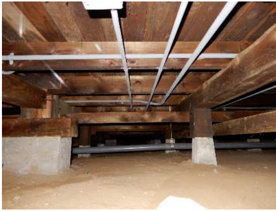
調査写真9. 床下の状況
