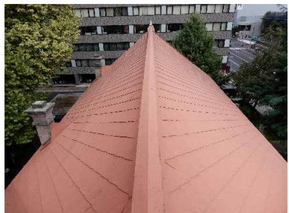
調査写真16. 垂鉛引鉄板葺の状況
