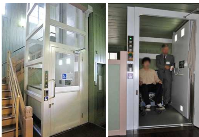
写真32 平成22年段差解消機設置後(左:1階、右:2階)
