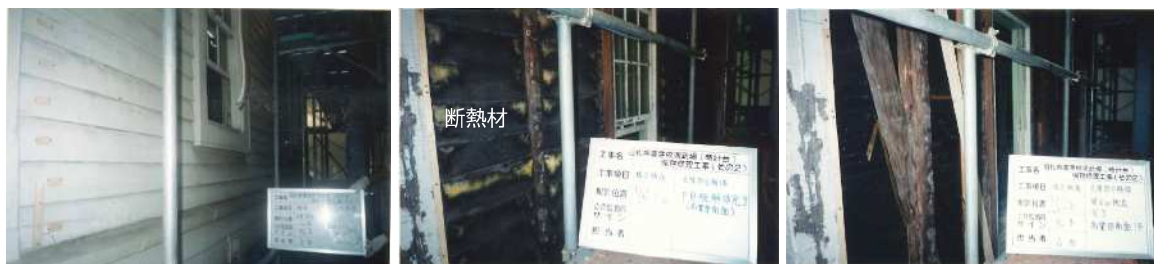
写真20 南翼屋南面外壁解体の写真(左:解体前、中央:下見板解体、右:断熱材撤去)
