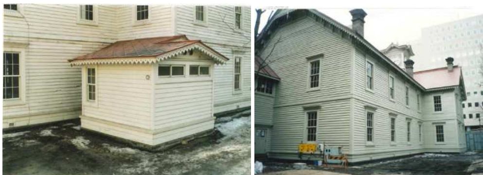
写真23 左:保存修理工事前 右:保存修理工事後
