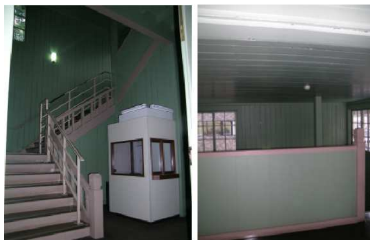
写真31 平成22年段差解消機設置前(左:1階、右:2階)
