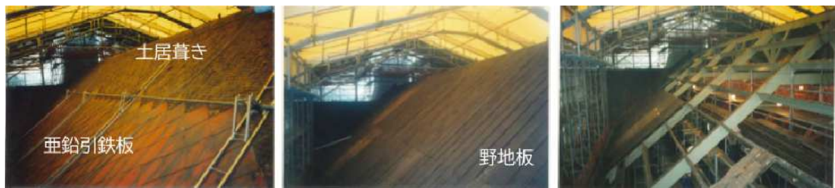
写真16 本屋屋根南側解体時の写真 (左:垂鉛引鉄板の解体中、中央:土居葺撤去、右:野地板解体後)
