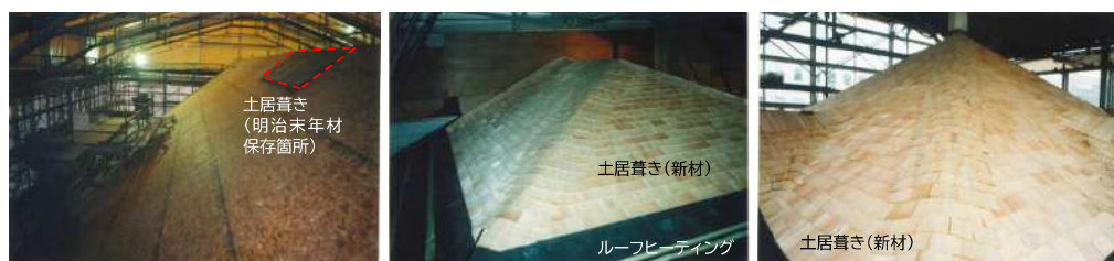
写真18 屋根の土居葺施工状況 (左:本屋北側中央部棟際(西から撮影)、中央:玄関屋根、右:時計塔屋根)
