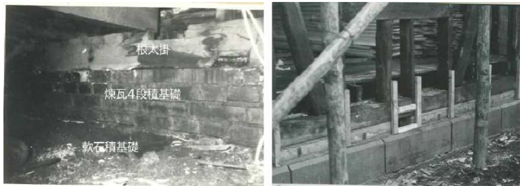
写真10 基礎改修(左:改修前、右:改修後)
