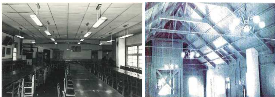
写真12 2階天井、間仕切撤去(左:改修前、右:改修後)
