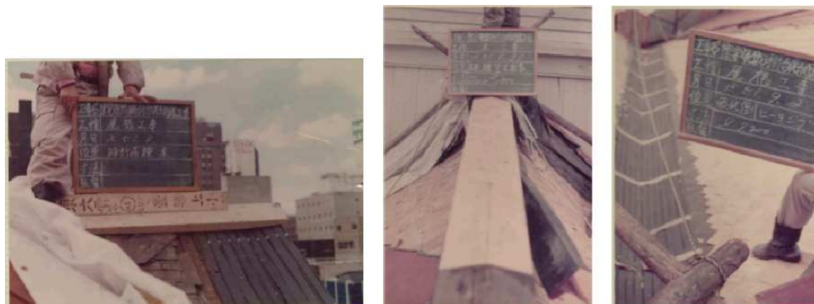
写真15 屋根の施工状況
