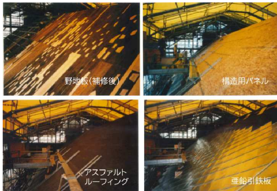
写真17 本屋屋根南側補強時の写真 (左上:補修済み野地板復旧、右上:構造用パネル設置、左下:ルーフィング敷、右下:垂鉛引鉄板葺)
