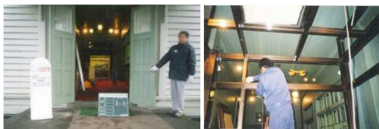
写真30 左:風除室設置前、右:平成14年11月設置中
