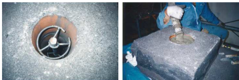
写真19 煙突の補強施工状況 (左:煙道内への鉄筋挿入後、右:煙道へのモルタル充填の様子)
