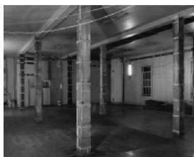
写真24 1階大展示室内の独立柱 (化粧板を剥がした状態) (出典:平成10年保存修理工事報告書)
