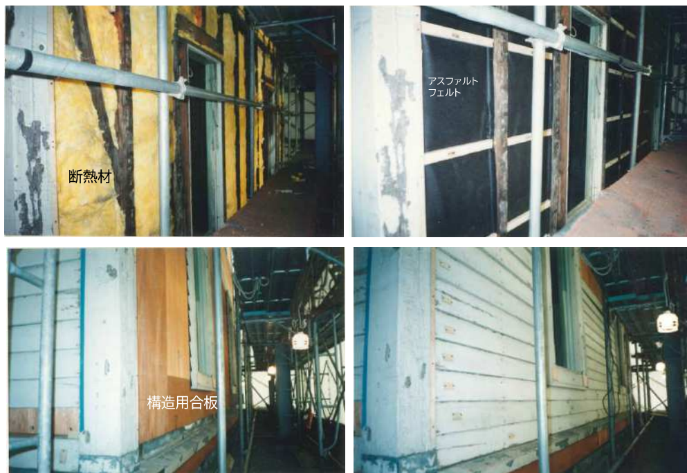
写真21 南翼屋南面外壁補強の写真 (左上:断熱材取付、右上:アスファルトフェルト張り、左下:構造用合板張り、右下:下見板復旧)
