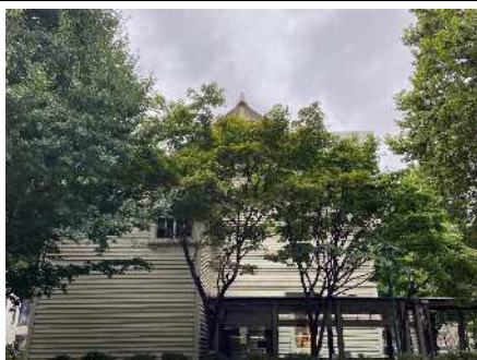
背面(東側)外観
