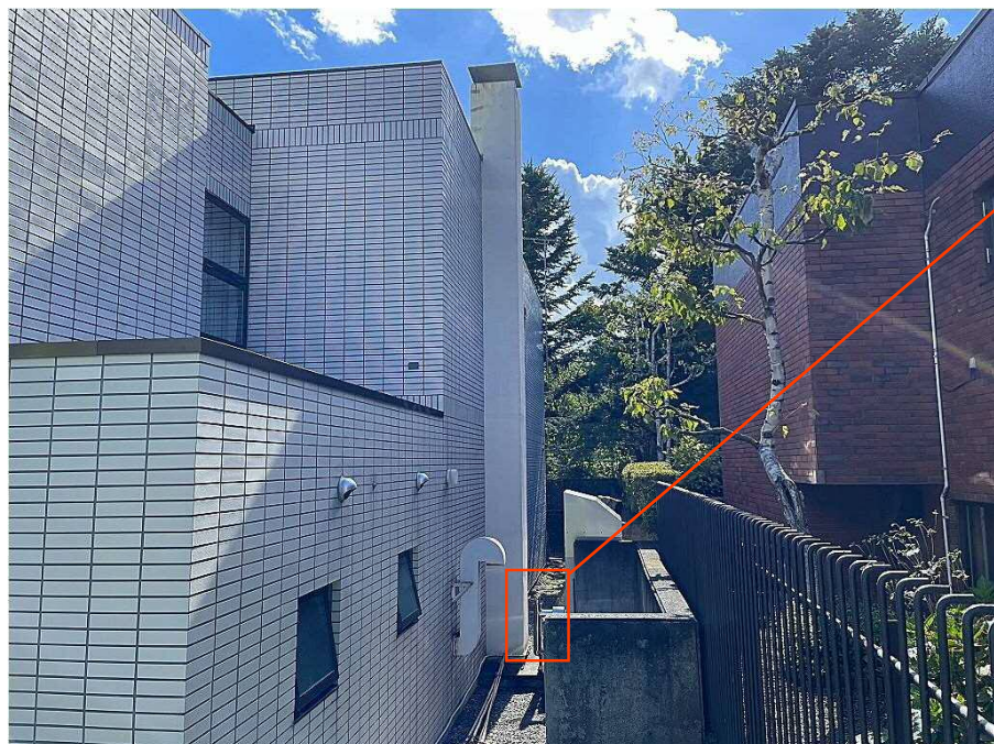
【煙突全景（北西面）】
