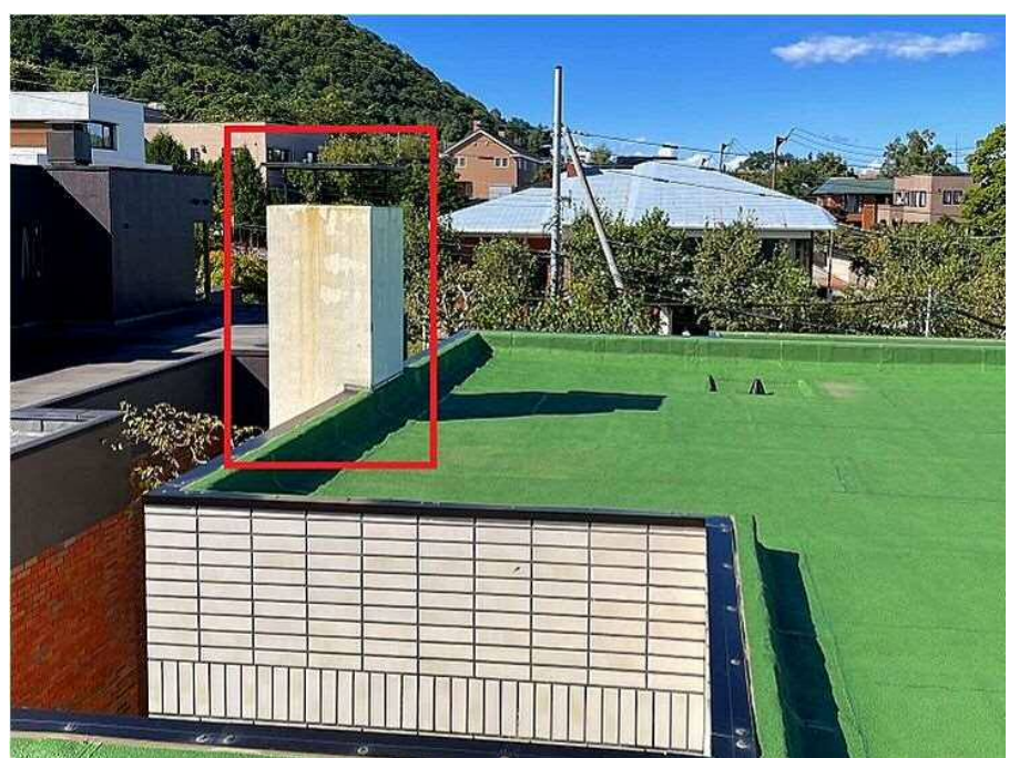
【煙突頭頂部（南東面）】
