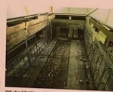
既存基礎に増設用基礎配筋の様子 鉄筋コンクリート敷設
