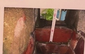
煉瓦の規格は112mm×233mm×55mm
