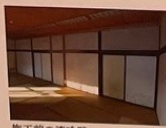
施工前の漆喰壁
