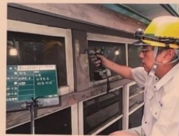
塗装面研磨による塗装履歴の確認
