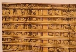
下塗土壁の下地「葦」で組まれた小舞
