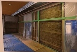
和室漆喰壁撤去の様子
