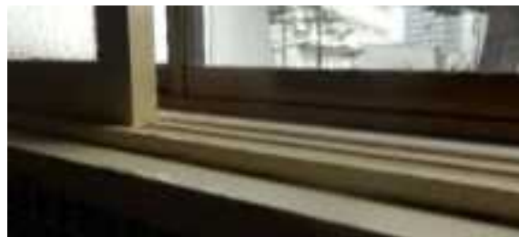
※窓枠(木製)の損傷
