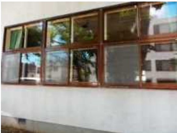
壁塗装の劣化による汚れ
