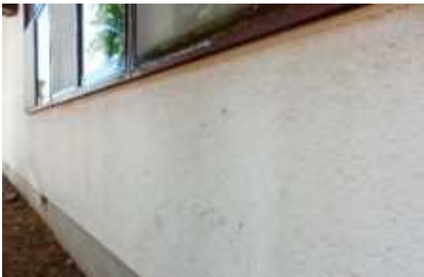
壁塗装の劣化による汚れ
