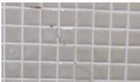
※壁タイルのひび割れ
