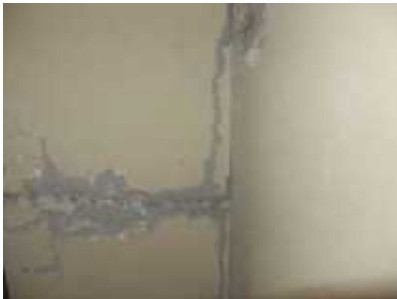
※壁の亀裂、破損、汚れ
