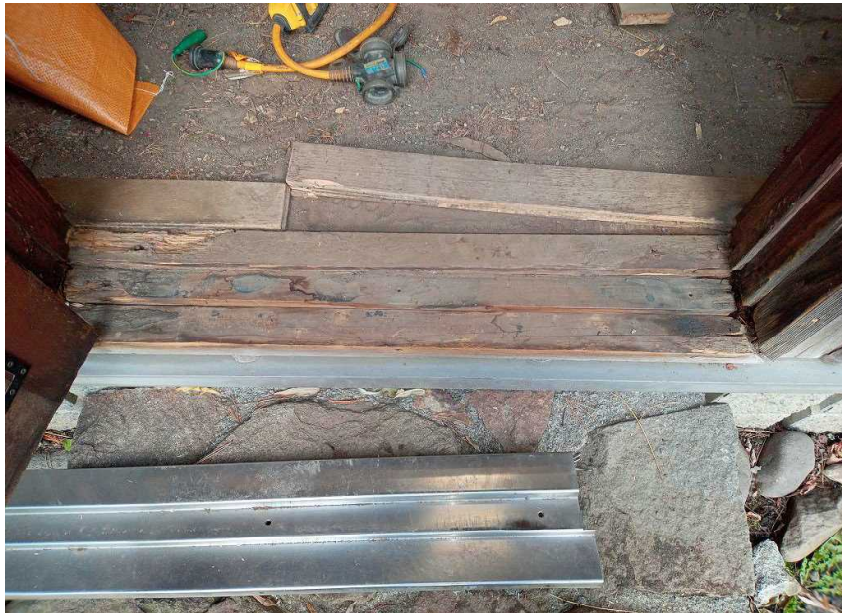
敷居ステンレスカバーを 外した状態
