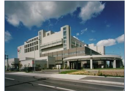
廃棄物発電を行う白石清掃工場（左記①）
