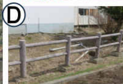
・樹脂製擬木柵外側に碍子を取付け3段張り
