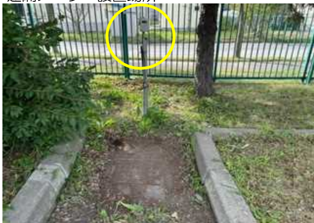
遠隔メーター設置場所
