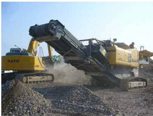
移動式コンクリート破碎機
