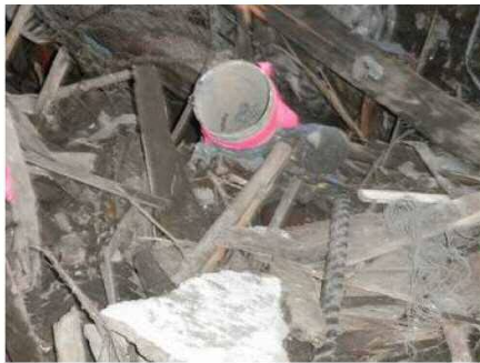
火災予防対策（ガス抜き管の設置） 岩手県宮古市都運動公園二次仮置場
