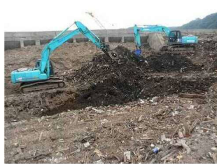
重機による災害廃棄物の山の掘削 岩手県宮古市田老一時仮置場
