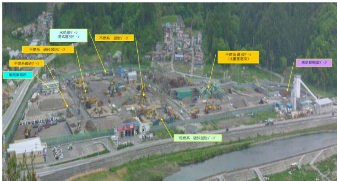
二次仮置場の施設配置例(岩手県大槌地区)
