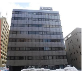
ボックスを設置した北4条ビル テナントが32入っている大きなビルです。
