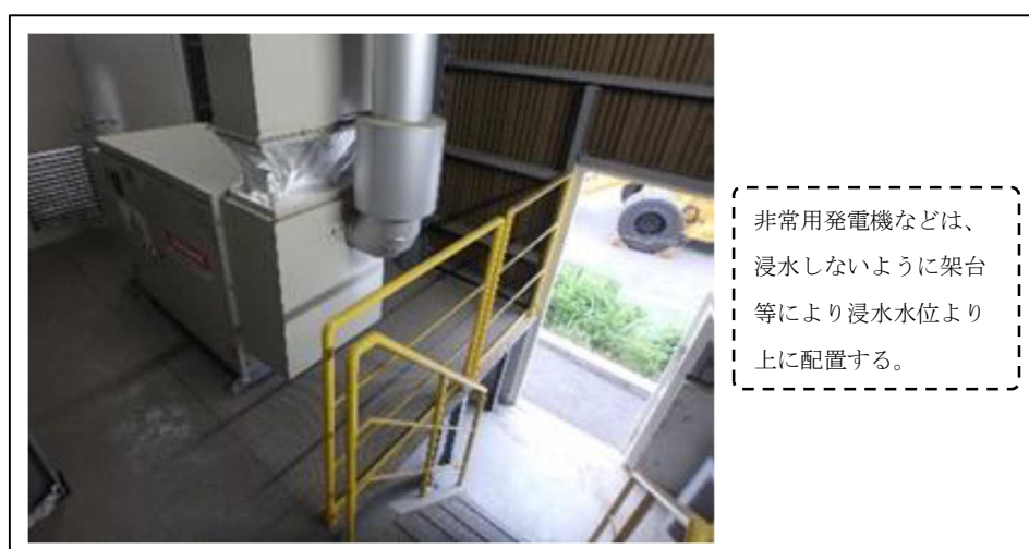
図 6.8 非常用発電機の浸水対策の事例
