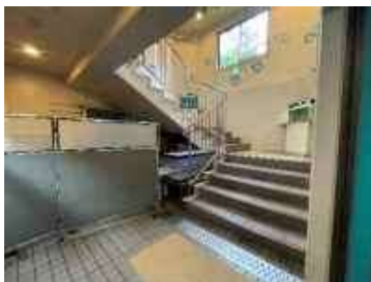
本館 1 階への階段（地下かんさつ室から）
