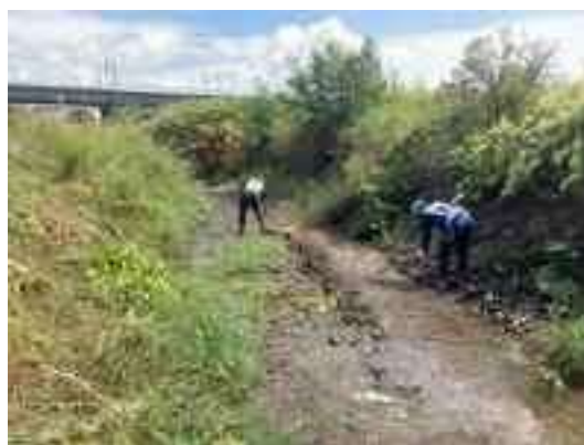
河川工事業者によるサケ産卵環境改善作業
