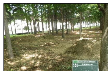
チップの敷き均し
