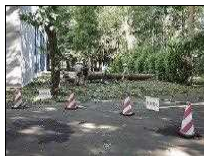
周囲の安全を確保し、複数名で作業する。直営での作業が難しい場合は専門業者へ委託
