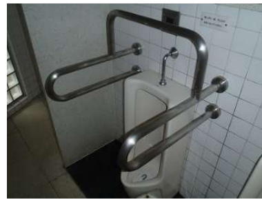
【小便器の手摺取り付け】
