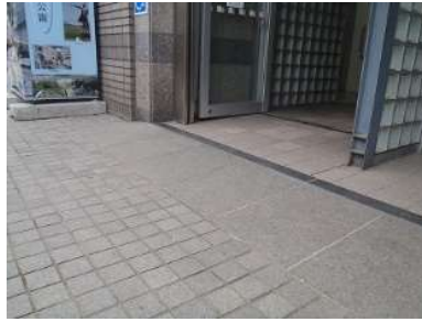
【公衆トイレ出入口の段差解消】
