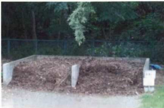
落葉の堆肥化ヤード
