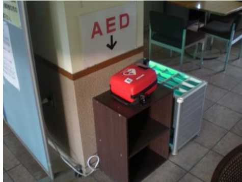
管理事務棟に設置してあるAED
