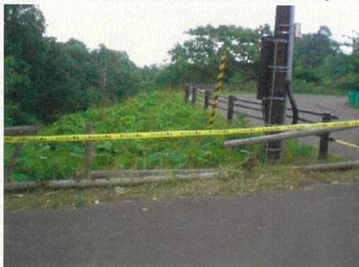
木柵破損状況及び立入禁止処置
