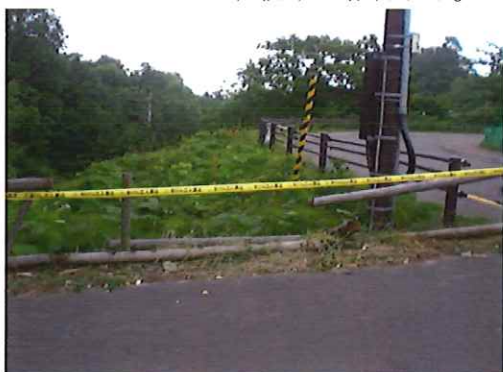
木柵破損状況及び立入禁止処置
