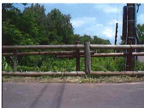
左写真の修繕後状況
