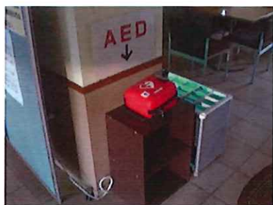
管理事務棟に設置 してあるAED
