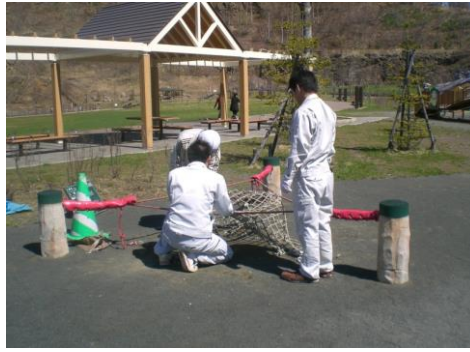
専門業者による遊具点検・修繕の様子
