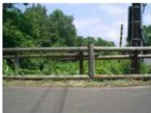
左写真の修繕後状況
