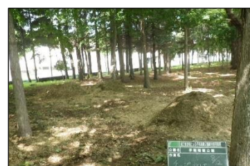
チップの敷き均し
